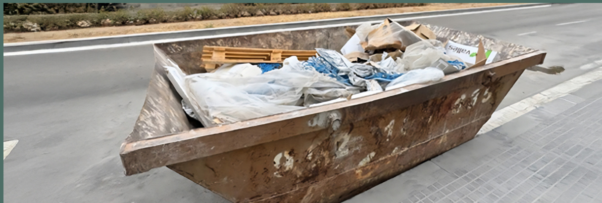
Gráfico 11. Contenedor en obra con residuos mezclados (LER 170904).
